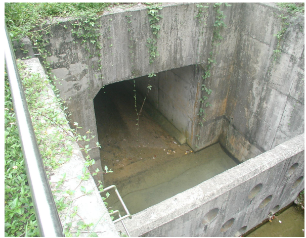
箱涵入口（又名流入工）
